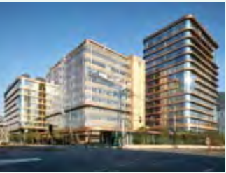
암스테르담 The Atrium 1, 2, 3 (네덜란드)
