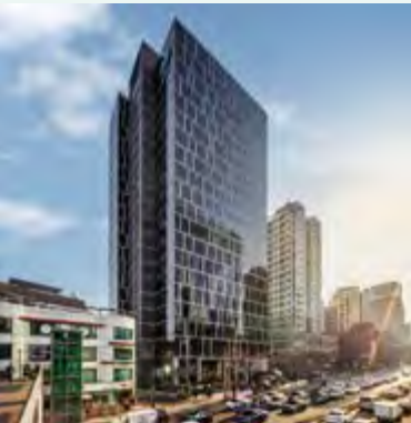
강남P타워 (서초구 소재) 폭설 시 건물 인접 도로 제설작업 실시, 지역사회 및 임차인 사고 방지
